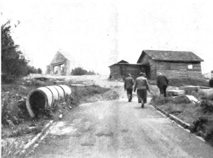
Ein Ausschnitt aus dem Ausbildungsgelände von Waldbröl, das laufend ausgebaut wird.
