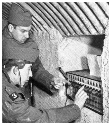
Im festgemauerten Unterstand bildet die Telefonzentrale den Knotenpunkt der Kabelverbindungen zur Front.
