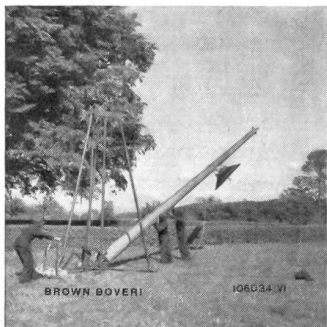
Aufbau des Antennenmastes
