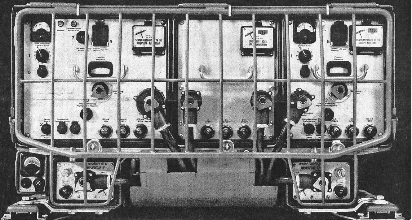
Die Funkstation SE 407, von der Autophon AG für die Schweizer Armee entwickelt, ist für den Einsatz in Panzern, Kdo-Fahrzeugen, Werkstattwagen usw. gebaut. Sender-Empfänger und Zusatzempfänger sind je für mehr als 100 Kanäle ausgerüstet, von denen sich mehrere vorabstimmen und über das Bedienungsgerät fernauswählen lassen. Speisung aus der Fahrzeugbatterie. Die Anlage ist robust und betriebssicher konzipiert, sie wird im Wechsel- oder Gegensprechverkehr und als Relaisstation eingesetzt.
