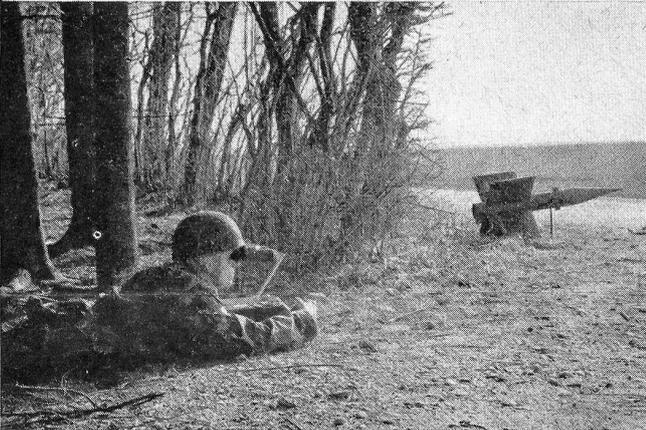
Die MOSQUITO wird ohne Abschussgestell direkt vom Boden gestartet, und der Schütze lenkt sie mittels eines Lenknüppels über elektrische Signaldrähte ins Ziel. Für Übungsschiessen wird der Kriegskopf durch einen Übungs-Fallschirmkopf ersetzt, womit die Rakete nach erfolgtem Fluge zurückgewonnen werden kann.
