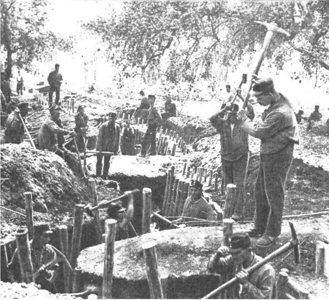
Schützengrabenarbeiten der Fortifikation Hauenstein. Das ganze Hauensteingebiet wurde stark befestigt als Abwehrstellung gegen Norden und Nordwesten und zum Schutz des wichtigen Eisenbahnknotenpunktes Olten
