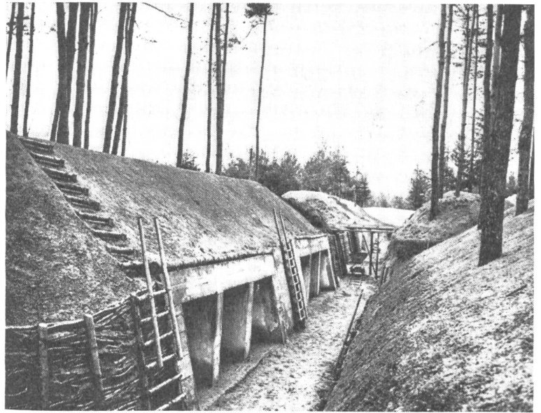
Betonunterstand in der Fortifikation Murten, die im Befestigungssystem von 1914/18 eine Schlüsselstellung einnahm. In monatelanger Arbeit wurden die Verteidigungsstellungen von Genie- und Infanterietruppen gebaut
