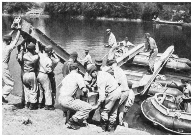
Bau einer leichten Uebersetzfähre aus Alu-Brückengerät
