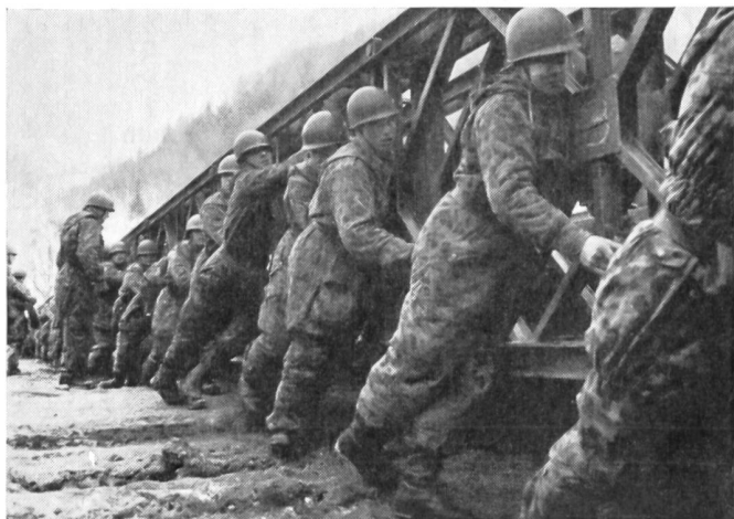
Vorschieben einer D-Brücke
