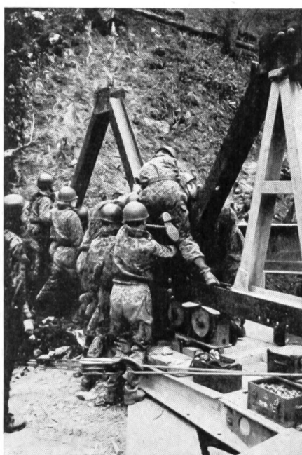
Zusammensetzen der D-Brücken-Elemente
