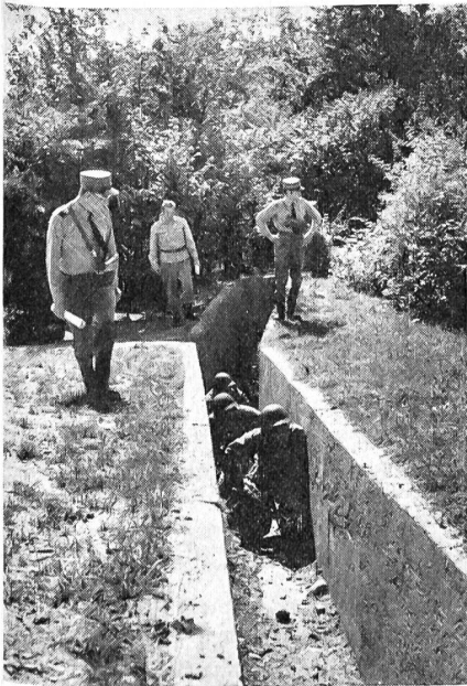
Verschiebung des Trupps in einem Grabensystem
