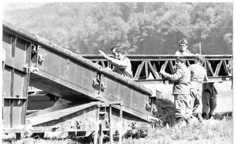
Die Brücke befindet sich am gegenüberliegenden Ufer. Der Schnabel wird abgebaut.
