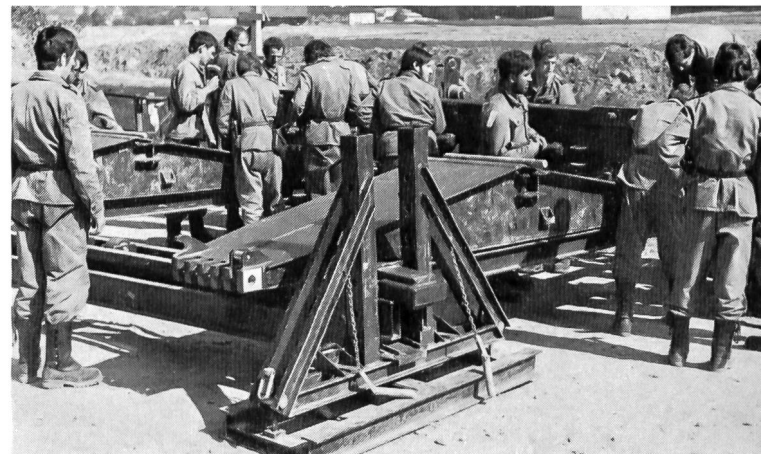
Montage des Uferbalkens auf die Auflagerdreiecke
