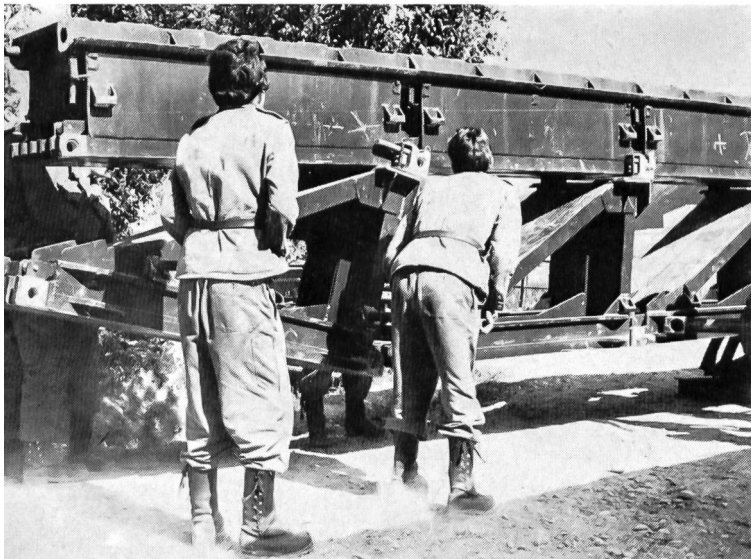
Einbau eines Fachwerkelementes
