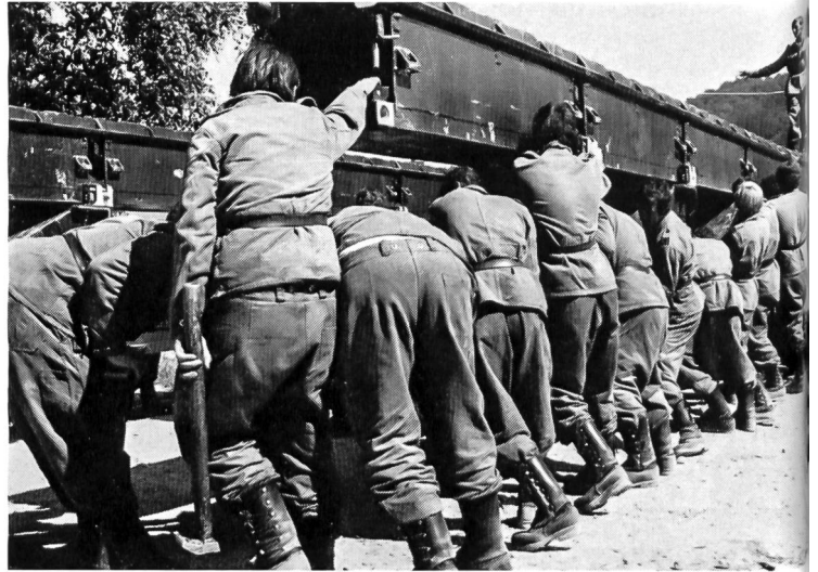
Schieben der Brücke
