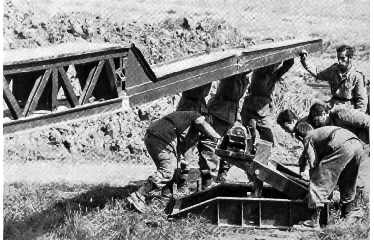
Das Auflaufrollenlager wird unter dem Schnabel bereitgestellt.
