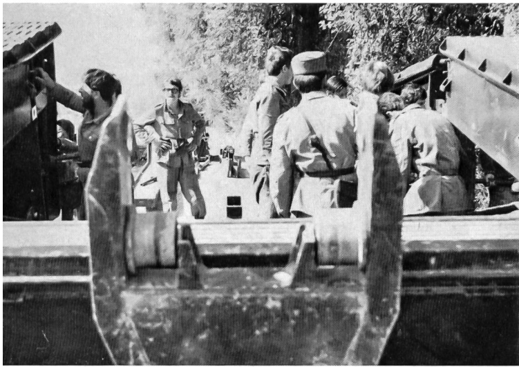
Schnabelrolle: Gut sichtbar sind die Rollen, auf denen der Schnabel vorgeschoben wird.
