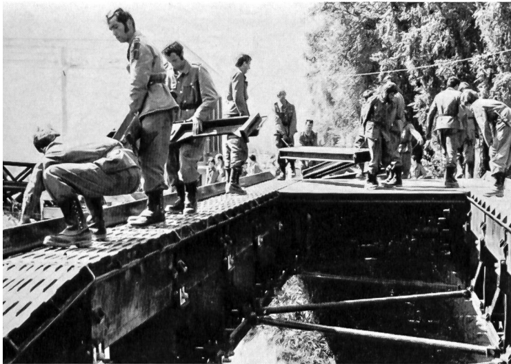
Einbau der Fahrbahnplatten und Randbleche
