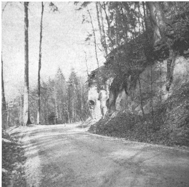
Zerstörungen an der 2.-Klass-Strasse Wolei—Woleiberg. Sprengstelle Nr. 2. Die Naturstrasse wird zwischen Felswand und Steilhang auf eine Länge von etwa 10 m abgesprengt. Verteidigung der Zerstörungsstelle: 1 Füsiliergruppe im Widerstandsnest Rank.
