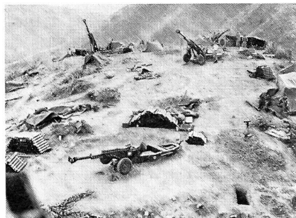
Foto H: Bau einer Feuerunterstützungsbasis
