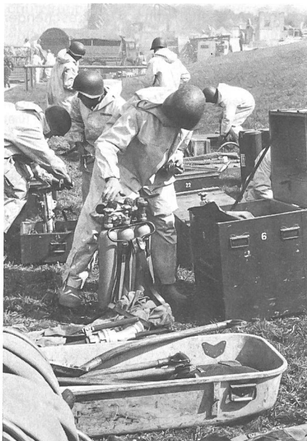
8 Grosser Zeitdruck entsteht beim Bereitstellen des Materials. Von der Geschwindigkeit der Arbeitserledigung hängen jetzt vielleicht im Ernstfall Menschenleben ab. Bereitstellen des Schweißbrenners.
