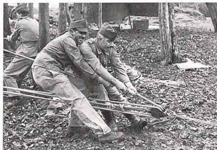
Die Seilstege müssen wacker angespannt werden, aber dennoch ...
