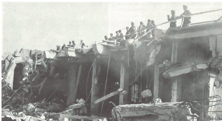
Aufmerksame Beobachter auf dem Dach der zerstörten Fabrik.
