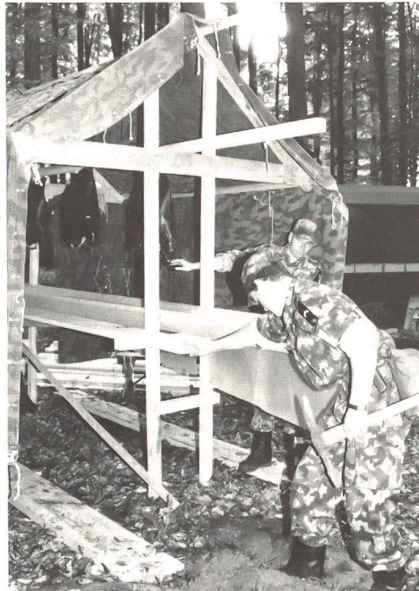
Beim Bau der notwendigen Installationen innerhalb eines Biwaks kann der Feldweibel seiner Phantasie freien Lauf lassen. Feldweibelschüler errichten eine Waschanlage.
