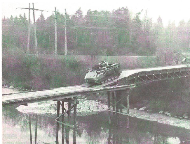
Pz Mw des Pz Rgt 9 (gelb) überquert die feste 50-t-Kombi-Brücke bei Kradolf am Di, 21. November.
