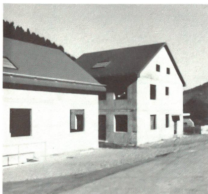
Notwendig waren die Bauten zur Übung von Häuser- und Ortskampf.
