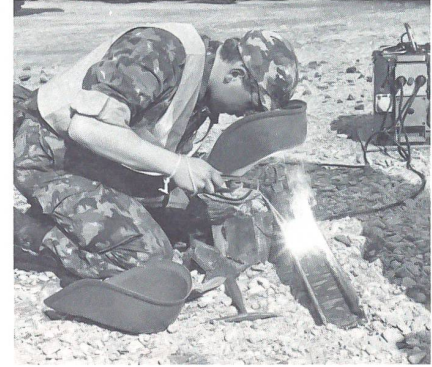
...und Schweißen müssen Eisenbahnsappeure ebenfalls können.
