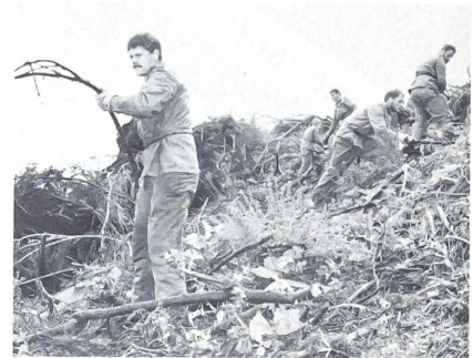
In mühsamer Kleinarbeit werden die Abhänge gesäubert.
