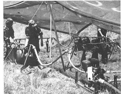
Abfüllstelle der Trinkwasseraufbereitungsanlage hinter dem Rheindamm.
