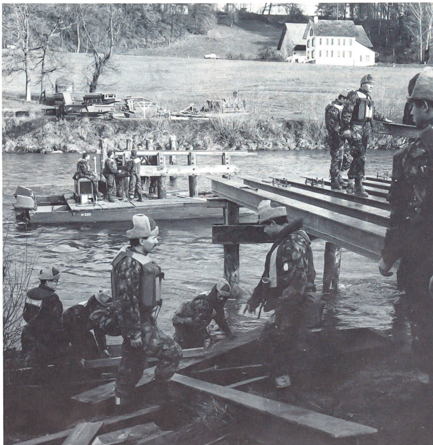
Sappeure des G Bat 6 beim Brückenschlag.
