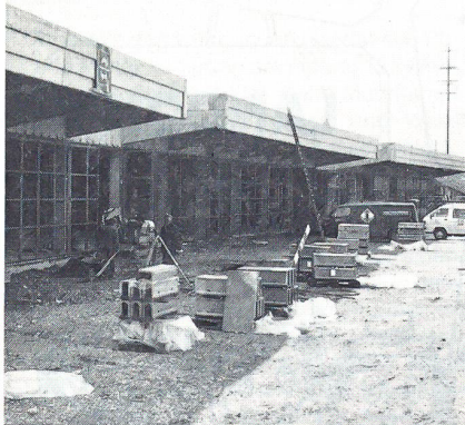
Die Toreinfahrten nehmen Gestalt an. Blick auf den Vorplatz Ende März 1991
