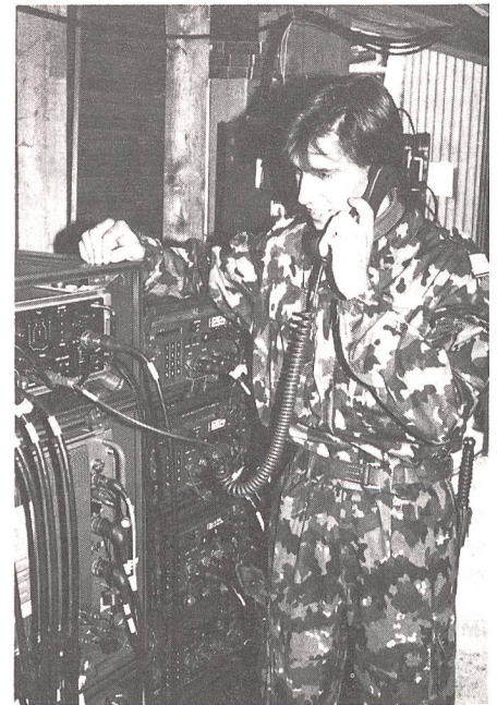
Uem Gtm Marc Zwygart bei der Überprüfung eines Knotenvermittlers (KnVm).
