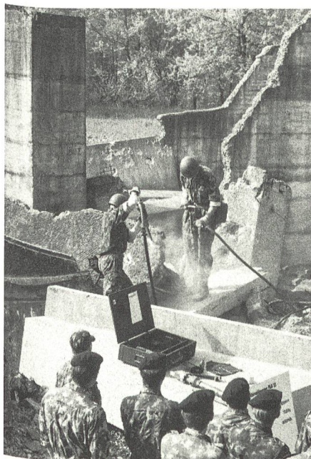
Demonstration des Abbruch- und Bohrhammers
