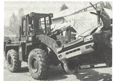
Baumaschinen werden eingesetzt, um den Weg freizuräumen.
