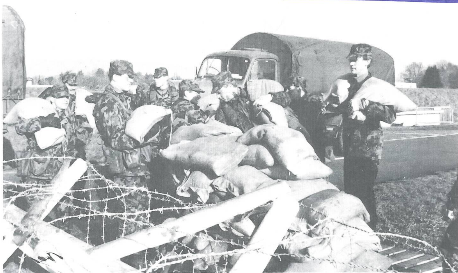
Angehörige der Füs Kp III/74 beim Stellungsbau auf dem Gelände des Flughafens Cointrin.
