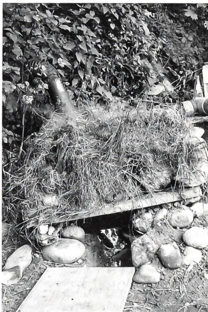
Die Seitenansicht des Koreaofens. Unten der Zugang zur Feuerstelle
