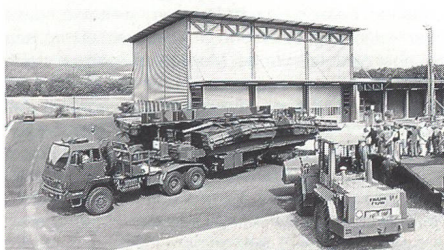
Die neue Basiswerkstatt für Schwimmbrücken und Rammgeräte. (Foto: Arthur Dietiker)
