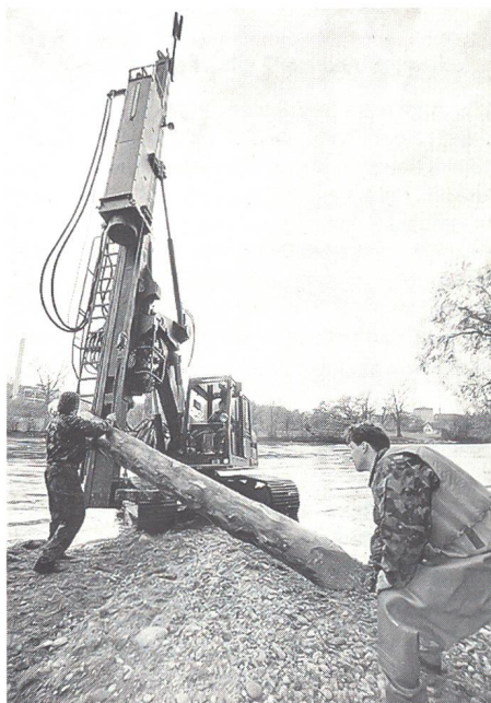
Ein Rammbagger des G Bat 36 bei der Arbeit.
