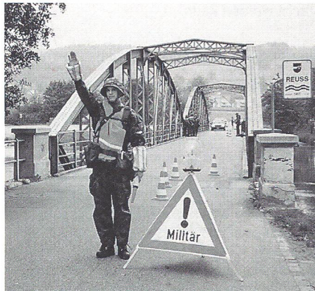
Regelung des Verkehrs beim Laden eines Sprengobjektes.
