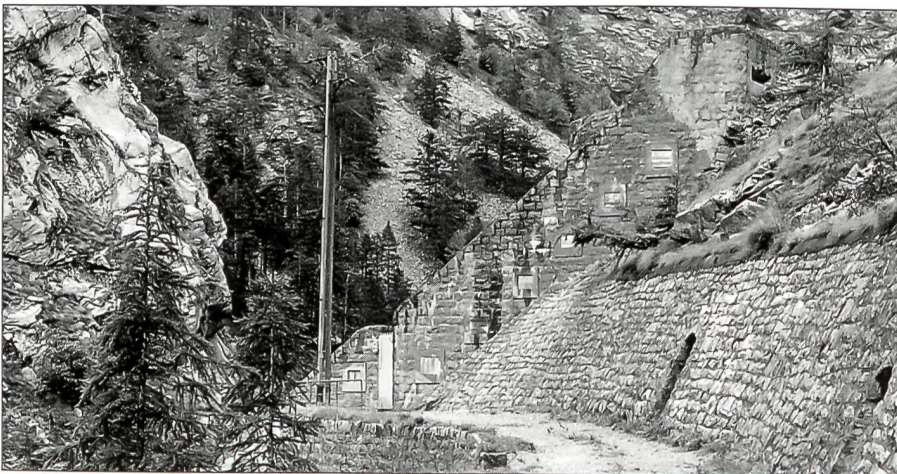
Zugang zum Festungswerk Gondo: Stützmauer mit Fluchtunterständen bei Steinschlag.
