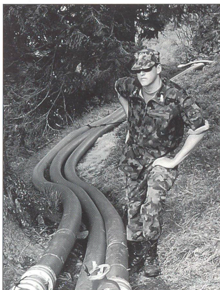
Oblt Schläpfer unterwegs bei den grossen Militärschlauchleitungen mit einem Durchmesser von 150 Millimetern und einer Durchflussmenge von gesamthaft 10 000 Litern Wasser pro Minute.
