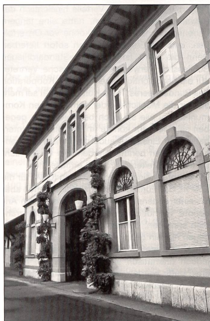
Eingang zum Kommandogebäude der ehemaligen Pferderegieanstalt in Thun/Schwäbis.
