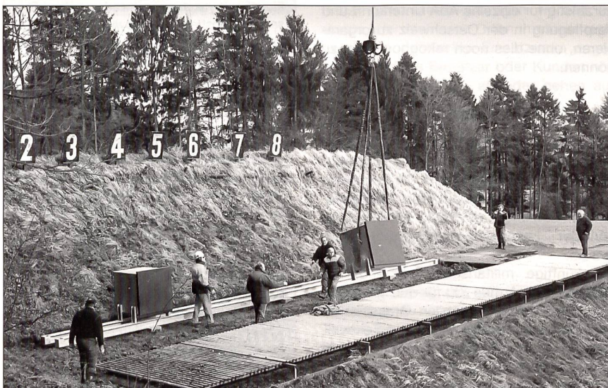
Präzisionsarbeit beim Setzen.
