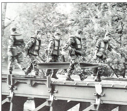
Beim Bau der Festen Brücke 69
