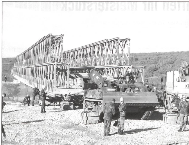
800-PS-Pionierpanzer zieht die auf Rollen gelagerte Brücke.
