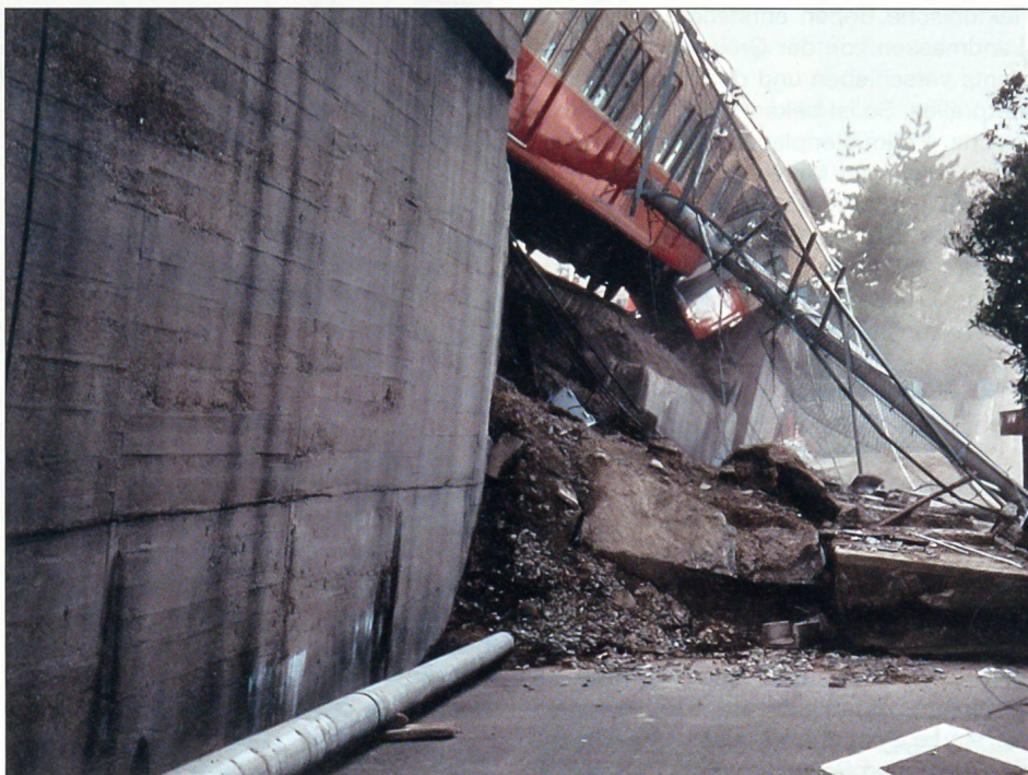
Zerstörungen an Verkehrsachsen und Werkleitungen.
