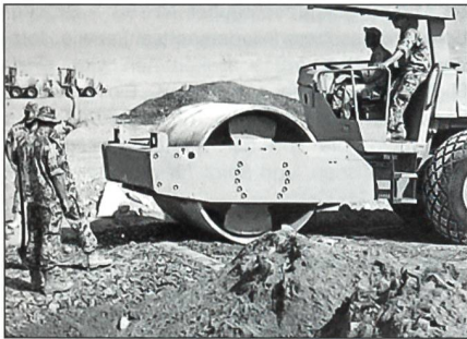
Baupioniere beim Strassenbau.
