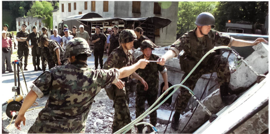
Die Bereitstellung der Betonpresse erfordert Massarbeit.
