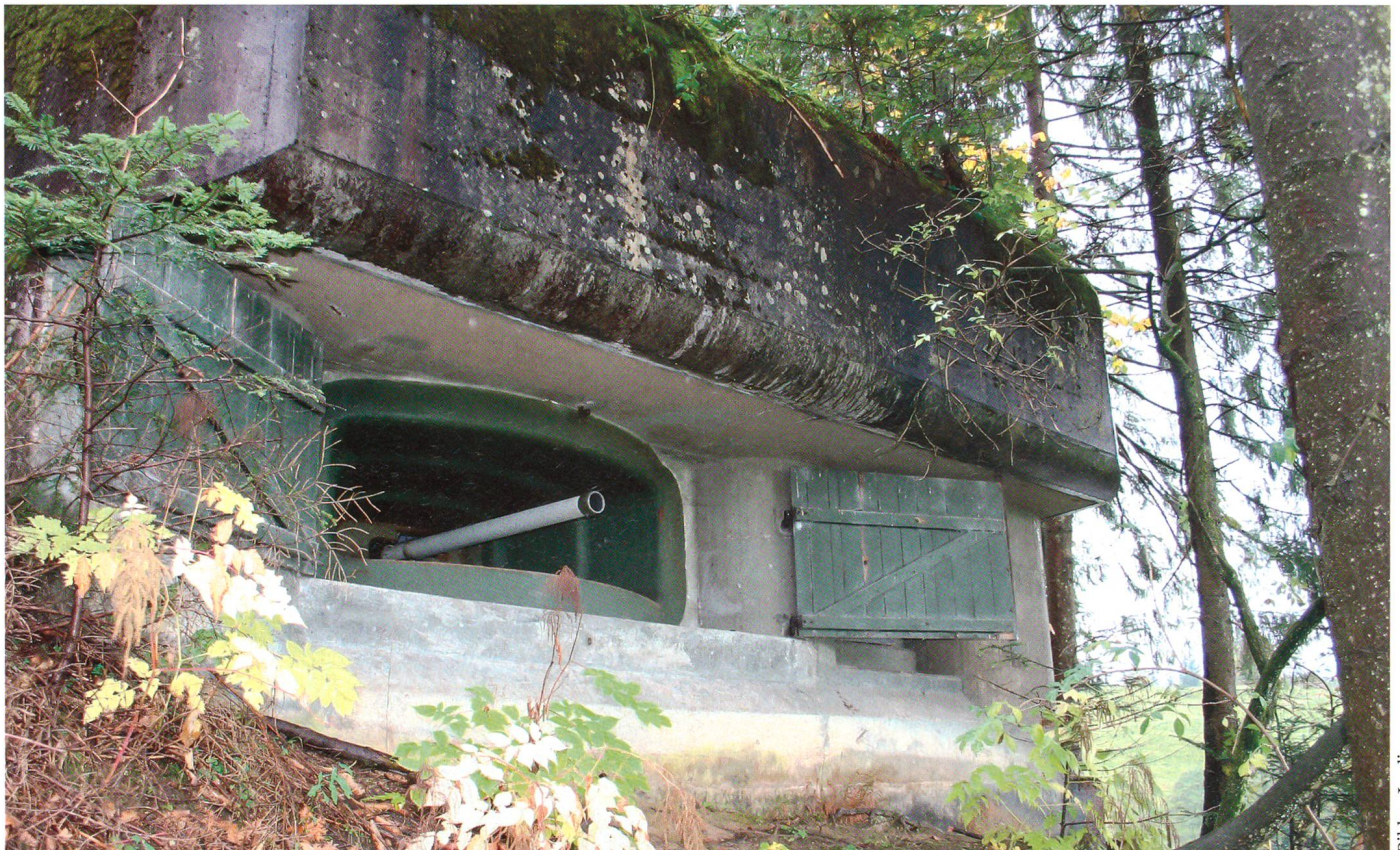
Gut getarnter Bunker auf dem Zugerberg.
