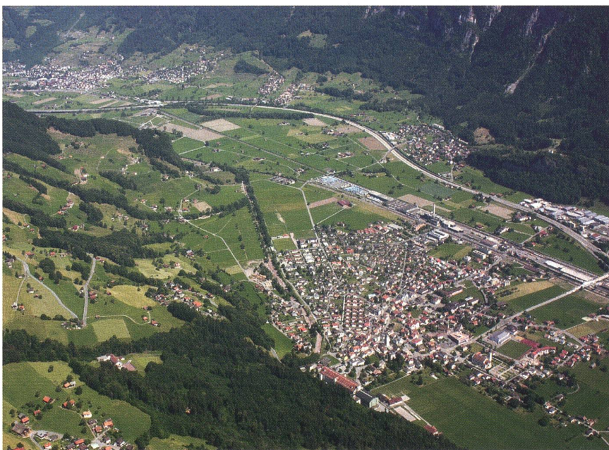
Die Gemeinde Flums hat sich von der Katastrophe erholt. Oben die Autobahn A3.
