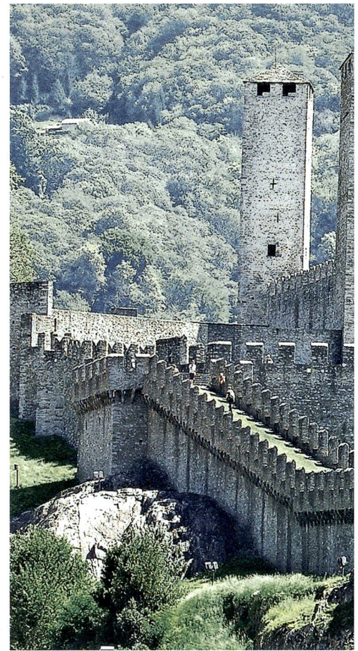
Befestigungsanlagen von Bellinzona.
