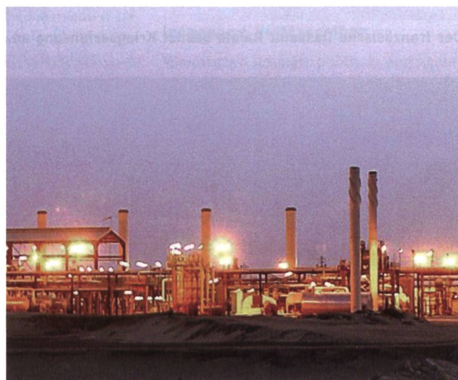
Aufbereitungsanlage bei der Oase Jakhira.
