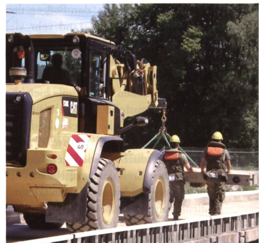
Am Mittwochmorgen bauen die Sappeure die hölzerne Fahrbahn ein.
