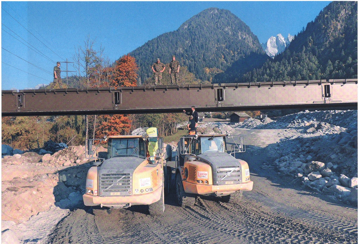
Die Armee baute eine sichere Zufahrt samt der Brücke über die hochfrequente Dumperpiste.
