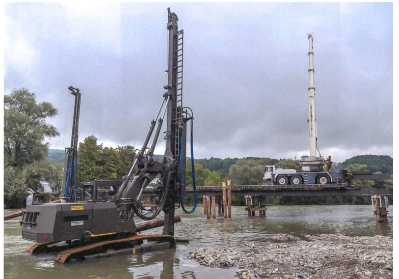
Mit Dieselramme werden die Brückenfeiler eingesetzt.
