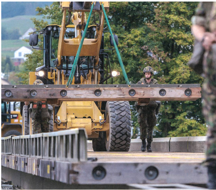
Sappeur beim Bau einer Stahlträgerbrücke.
