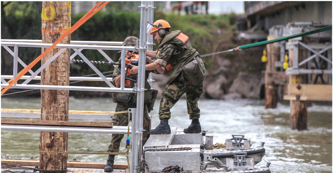
Rammpontoniere beim Bau von Brückenfeiler.
