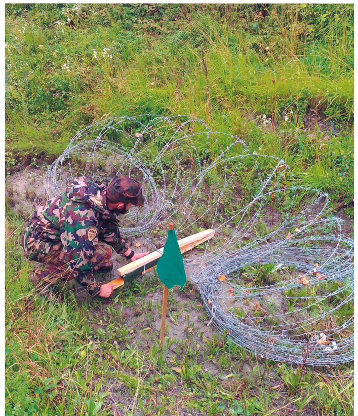
Eine gestreckte Ladung wird während des formellen Sprengens zur Wirkungsdemonstration unter einer Stacheldrahtrolle installiert.
