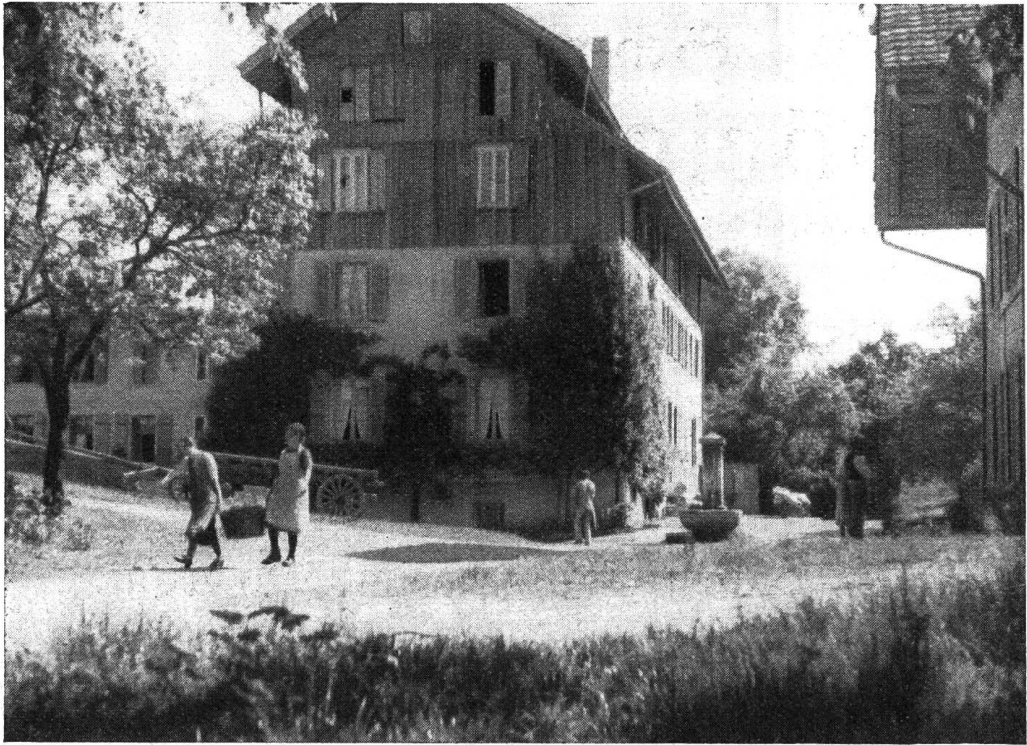
Ansicht des Heims von Westen.
