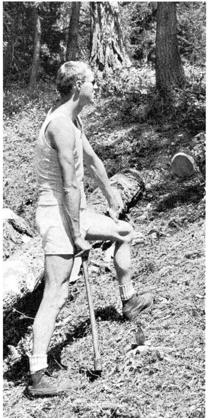
Dieser junge Mann hat seine ganzen Ferien dieses Jahr freiwillig geopfert, um beim Bau der Straße Albinen—Torrentalp mitzuhelfen.
