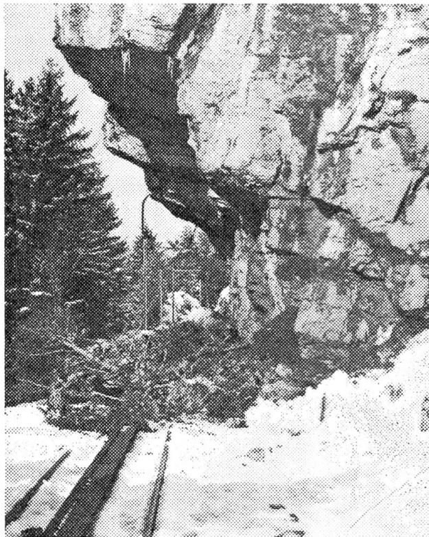
So sah es vor der Sprengung aus.
