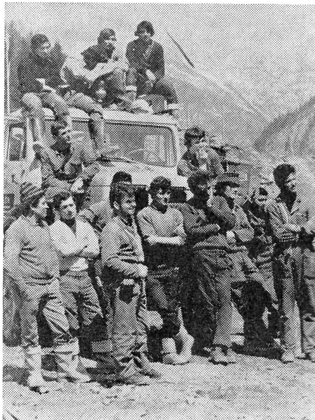
Die Fremdarbeiter — über ihr Schicksal und unseren Wohlstand wurde am 6. und 7. Juni für lange Zeit entschieden. — Unser Bild zeigt eine Gruppe von ausländischen Arbeitern, welche am Durchstich des neuen Gotthardtunnels arbeiten.
